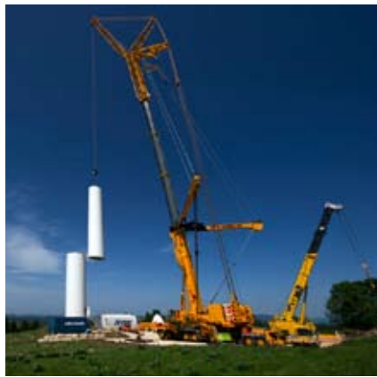
Mt-Crosin: la plus puissante grue du monde
