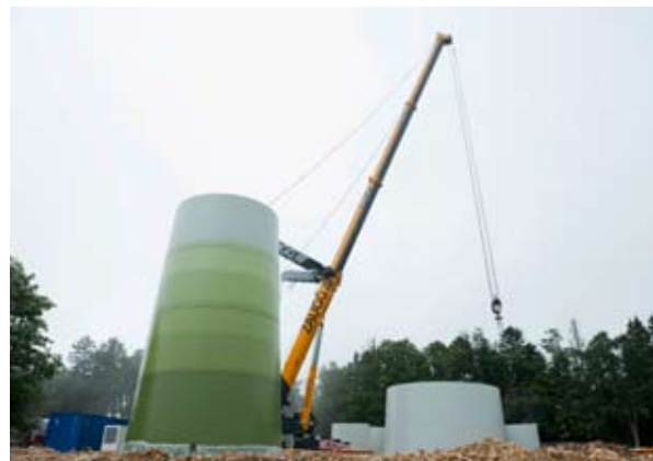
Le chantier du Peuchapatte
