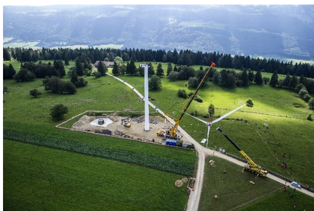
Éolienne remplacée: d'abord renouveler le socle
