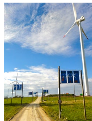
4 éoliennes remplacées, 6 fois plus de courant!
