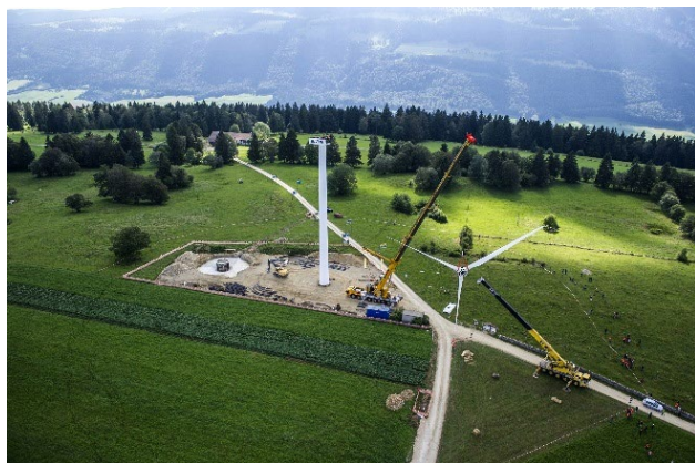
Abbau einer Altanlage. Links: neues Fundament
