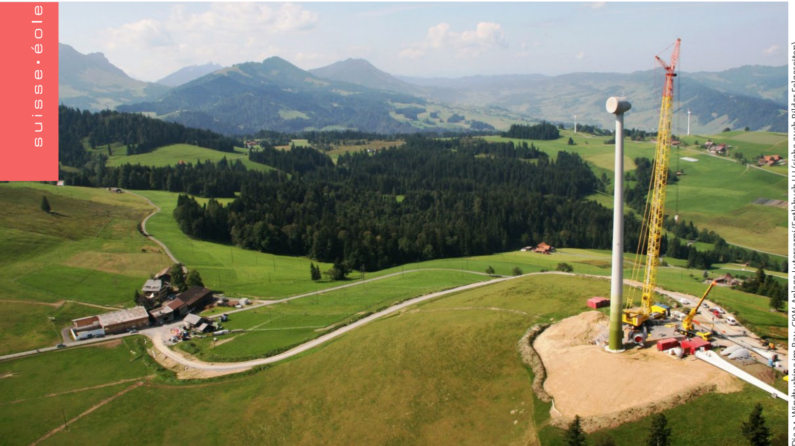
Die 34. Windturbine im Bau: CKW-Anlage Luttersarni/Entlebuch LU (siehe auch Bilder Folgeseiten)
