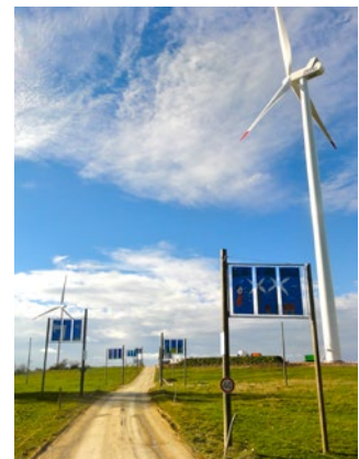
Repowering Mont-Crosin bringt 6-mal mehr Strom
