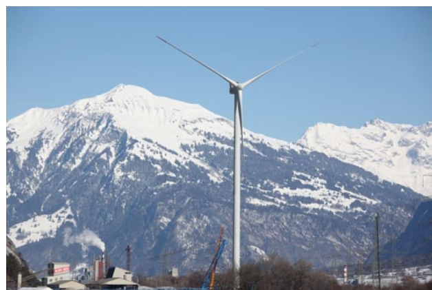
Haldenstein : le moyeu est à 120 m de hauteur
