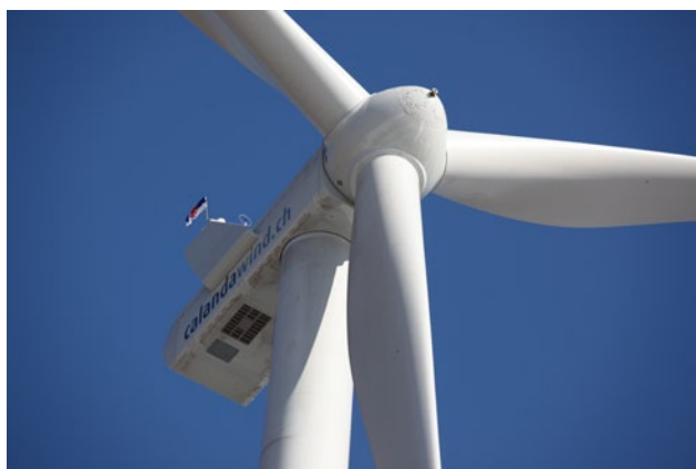
Imposante Gondel der 3-MW-Anlage
