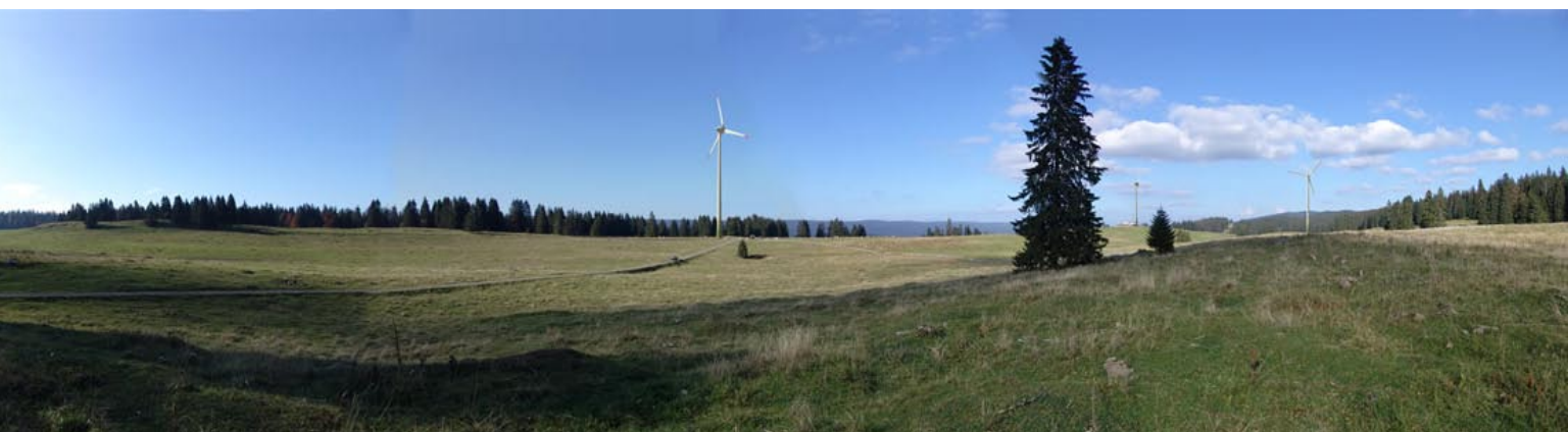
7 éoliennes pour alimenter à 100% la vallée de Joux
