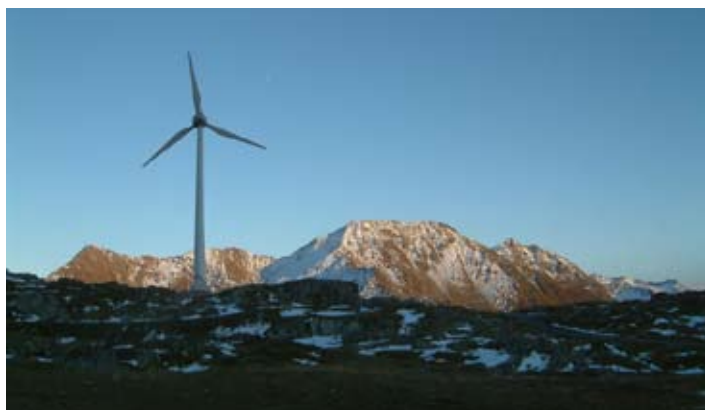
Gütsch: Ausbau mit Hindernissen
