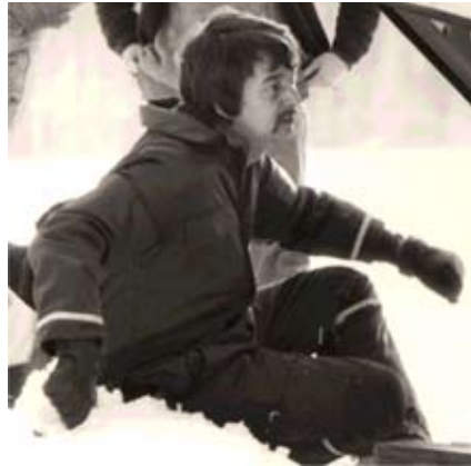
Pionier Horbaty montiert erste CH-Windturbine
