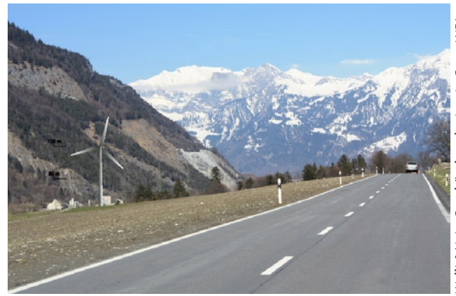
Wallis? Nein, Graubünden plant erste Gross-WEA
