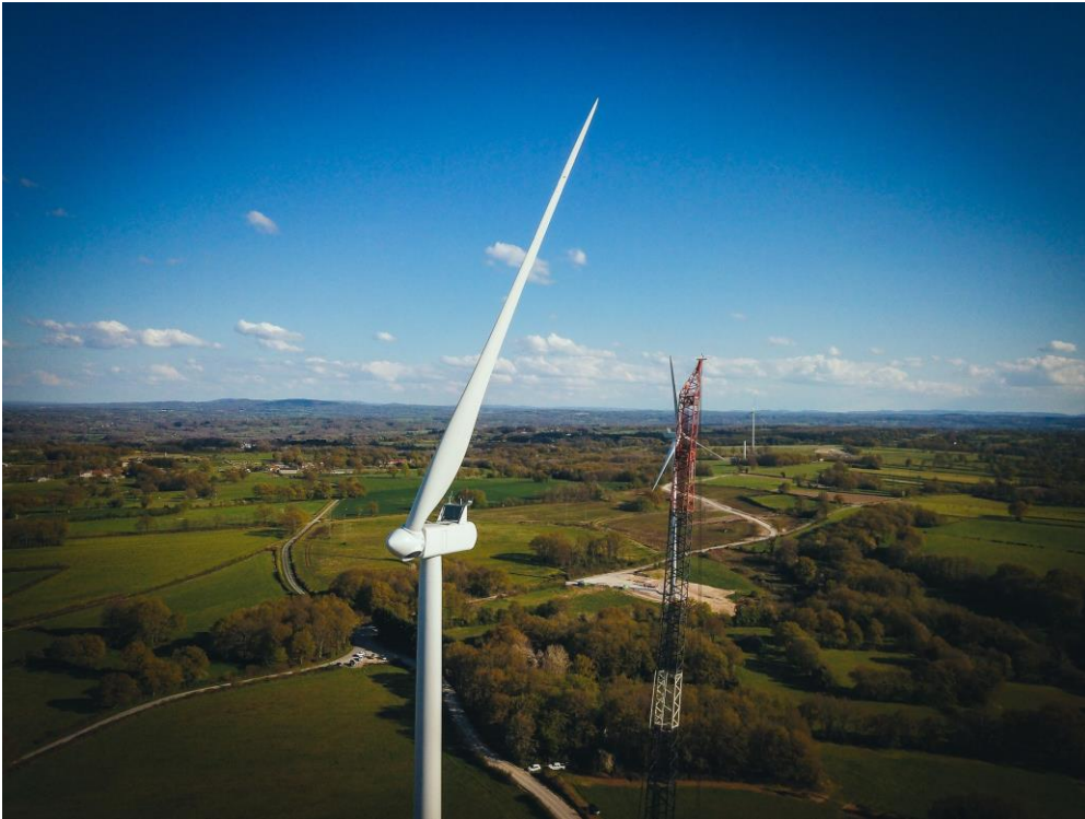
Windpark La Chapelle Baloue 8 MW, Frankreich
