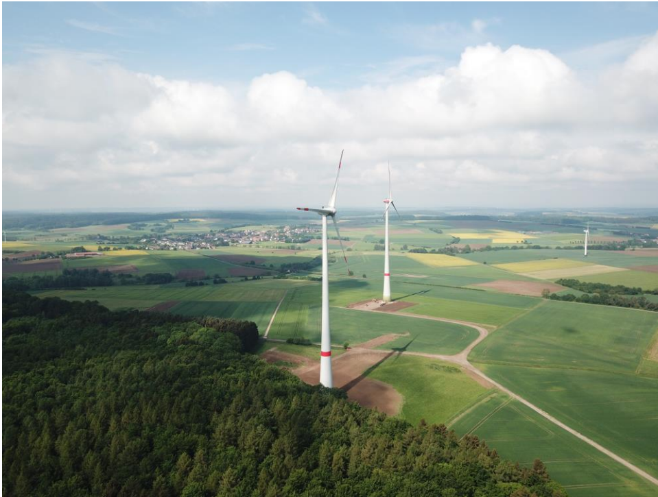
Windpark Romrod 15 MW, Deutschland
