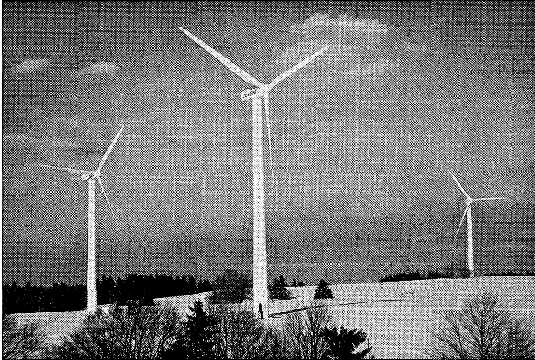
Windanlage auf dem Mont Crosin im Berner Jura. (Bild Bundesamt für Energie)
