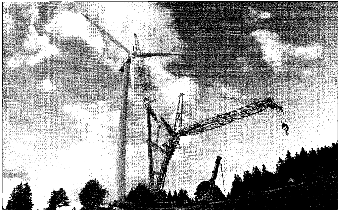
Montage d'une éolienne au Mont-Soleil (Jura bernois). Une infrastructure importée du Danemark.
